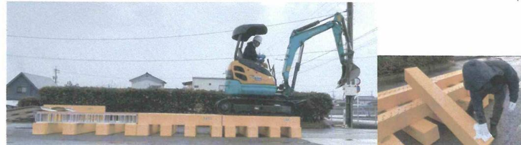
角度のある応急組立橋とする場合や、半恒久的に使用する場合には、専用の接着剤を用いて製品同士を接着固定させれば、より強度の高い応急組立橋を作ること可能です。
